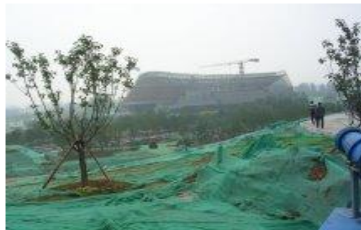
大建設中の中国館
