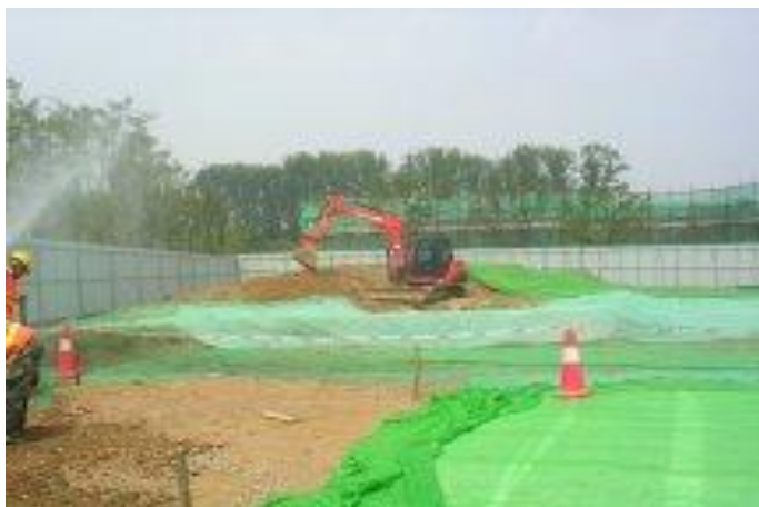
日本庭園の基礎工事
