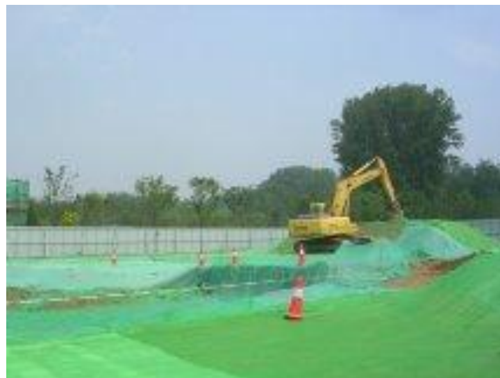
日本庭園の基礎工事
