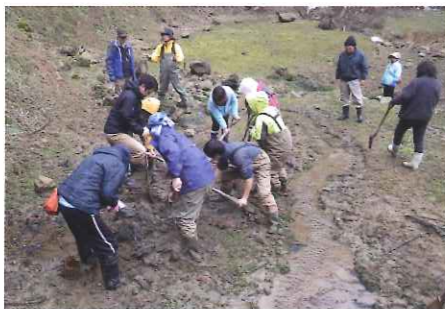
写真2 共同作業による畦の補修
