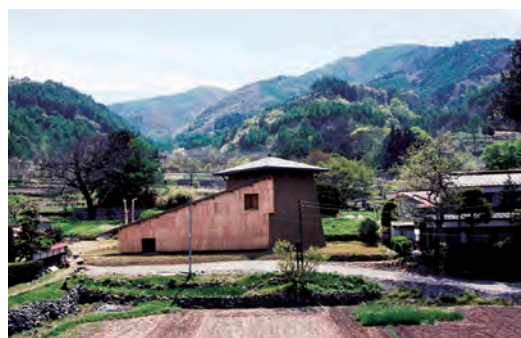
上 屋根は鉄平石。前方の壁は手割り板。 下 背後の山の奥に神の宿る守屋山がある。
